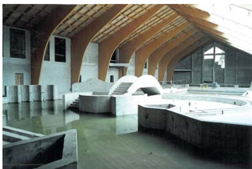
Basen w budowie – 2000 r.
